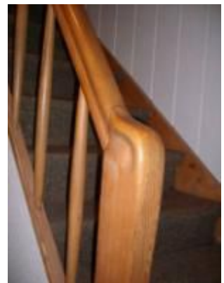
Die Treppe des Hauses Forststraße 80 ist im Bauantrag auf der anderen Seite gezeichnet. Ob der Treppenfosten und die Stabgeländer aus dem Jahr 1902 stammen, scheint mir zweifelhaft. Vielleicht wurde die Treppe für den Einbau des Lebensmittelladens auf diese Seite verlegt und erneuert?
